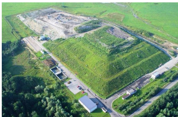
Obrázek č. 4 – Skládka odpadů S003 Solecká
