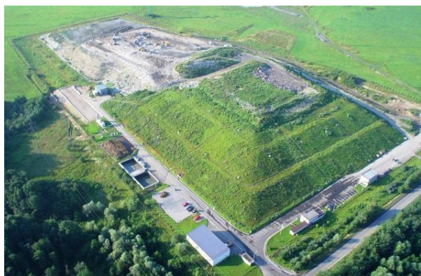
Obrázek č. 4 – Skládka odpadů S003 Solecká
